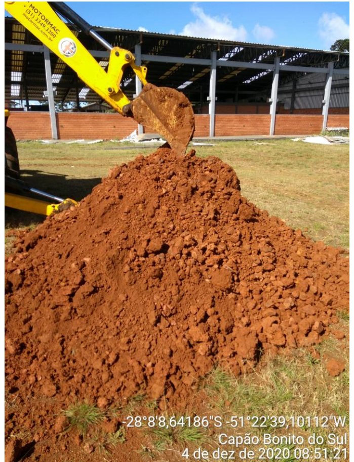
Figura 6 – Material escavado da segunda trincheira
