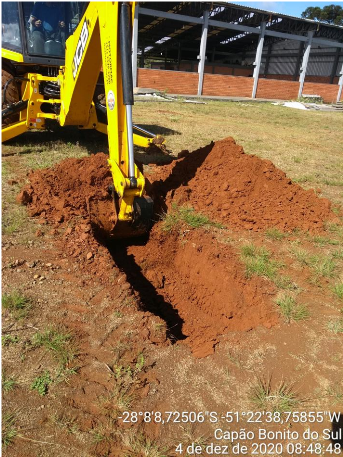
Figura 5 - Início da segunda trincheira
