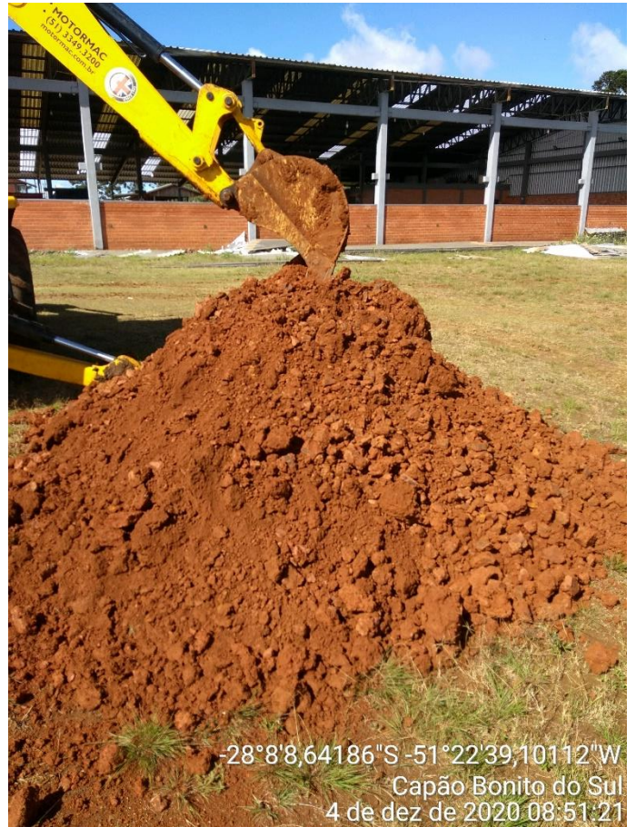
Figura 6 – Material escavado da segunda trincheira
