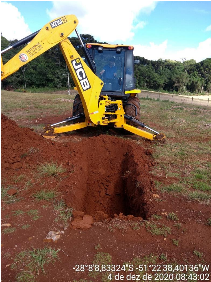
Figura 2 - Início da primeira trincheira
