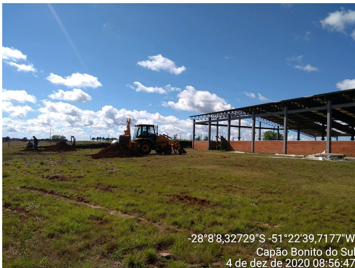
Figura 1 - Localização das trincheiras (ao fundo pavilhão existente)
