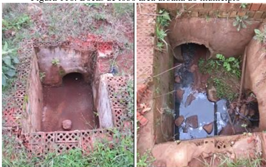
Figura 116: Bocas de lobo área urbana do município
