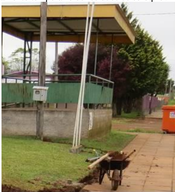
Figura 92: Acondicionamento temporário de resíduos de solo provindos de limpeza pública
