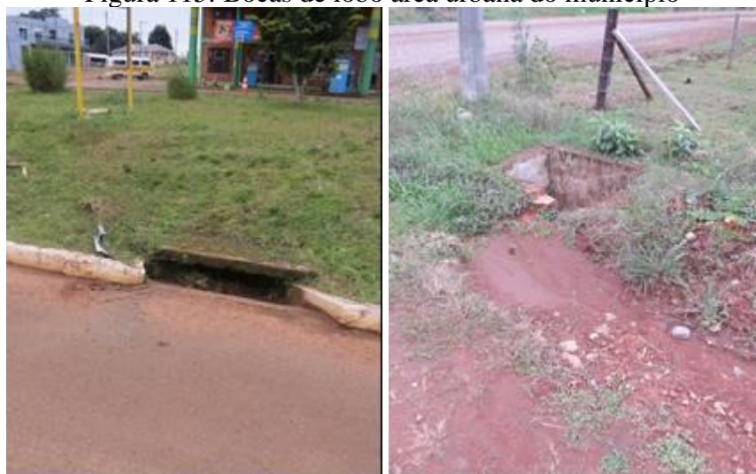
Figura 115: Bocas de lobo área urbana do município
