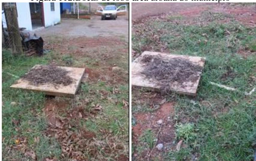
Figura 112: Bocas de lobo área urbana do município
