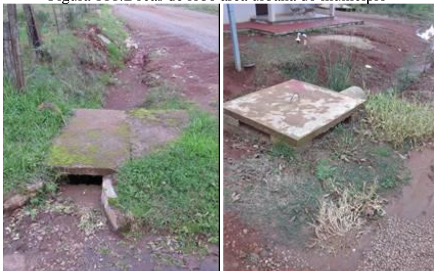
Figura 111: Bocas de lobo área urbana do município
