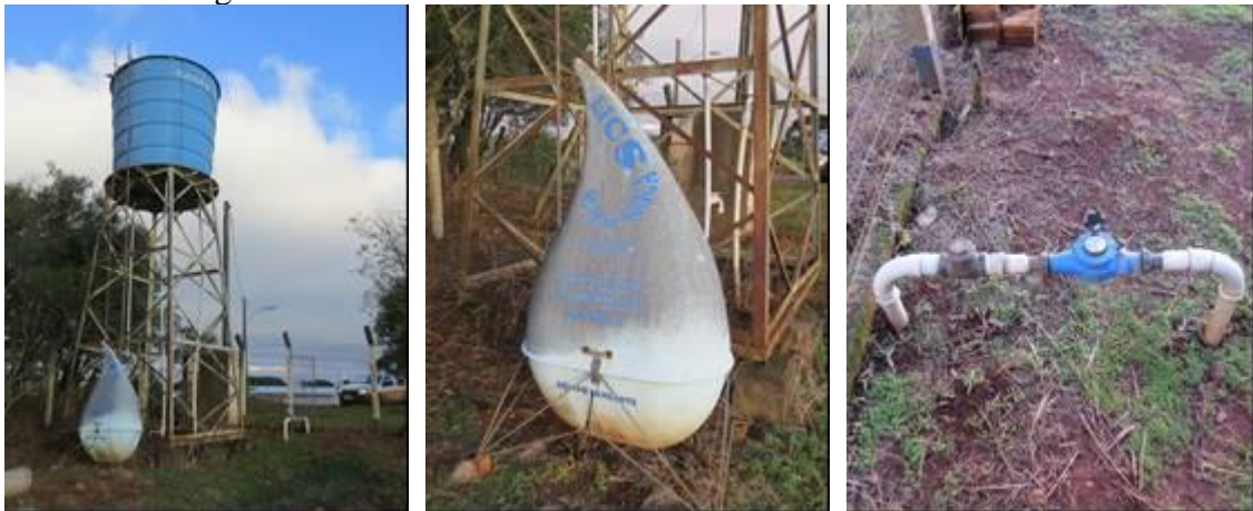
Figura 39: Reservatório localizado na Rua Vitorino Bolsonello
