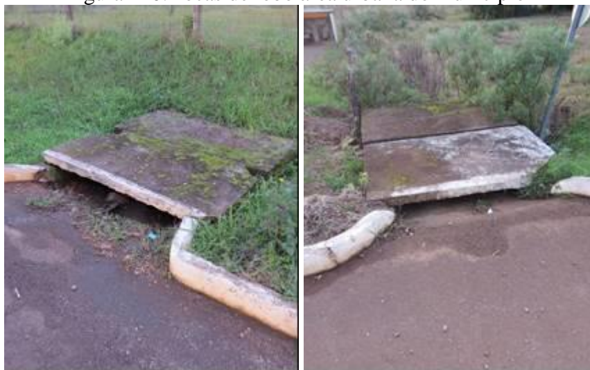
Figura 110: Bocas de lobo área urbana do município
