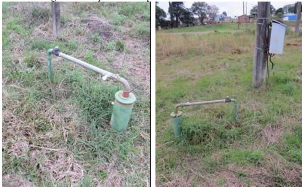
Figura 41: Poço artesiano presente na Rua João Bolsonello
