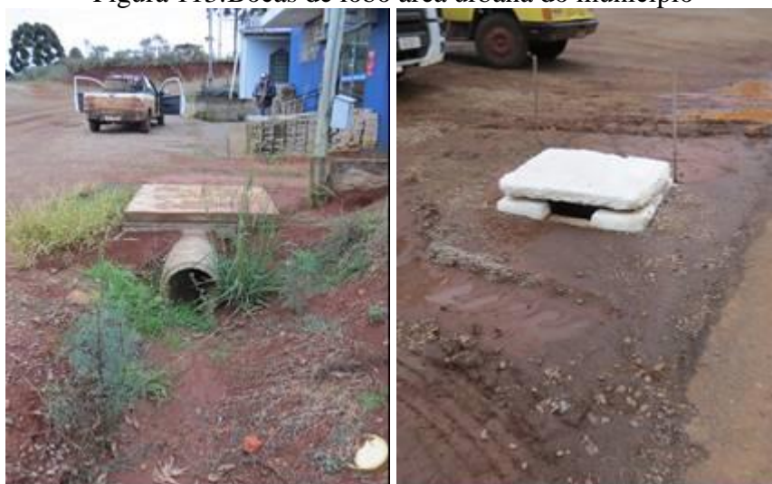
Figura 113: Bocas de lobo área urbana do município
