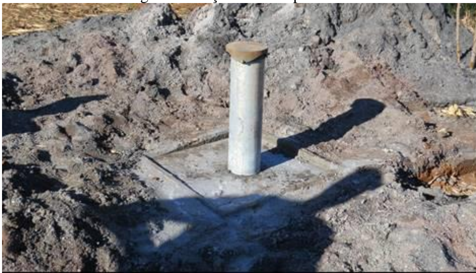
Figura 50:Poço artesiano perfurado
