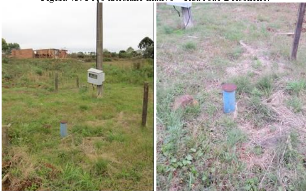
Figura 43: Poço artesiano inativo – Rua João Bolsonello.
