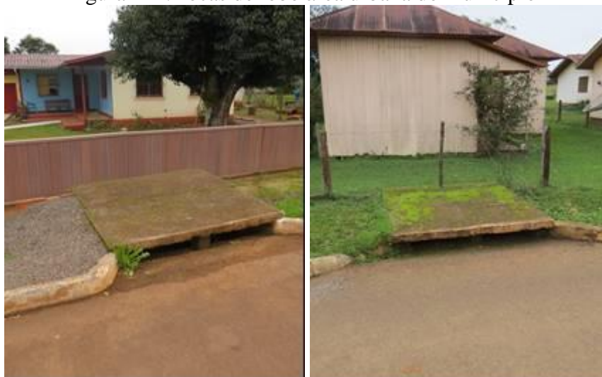
Figura 114: Bocas de lobo área urbana do município
