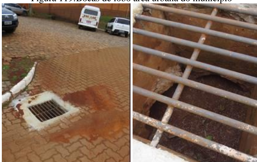
Figura 119: Bocas de lobo área urbana do município
