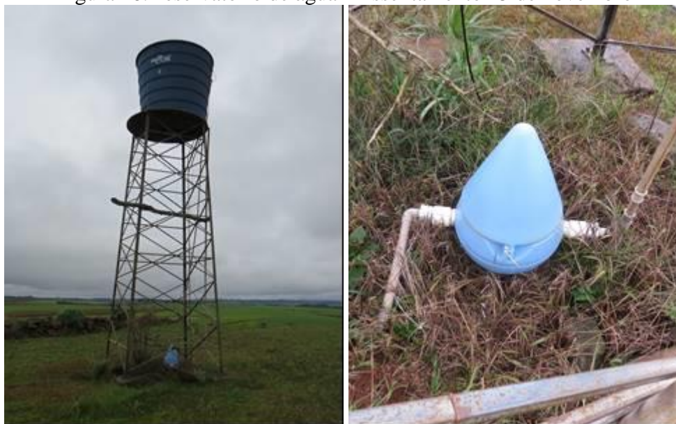
Figura 46: Reservatório de água - Assentamento 25 de novembro
