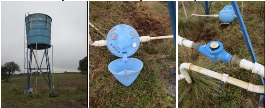
Figura 52: Reservatório de água– Rincão Comprido
