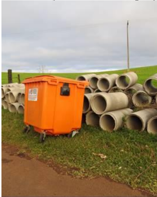
Figura 122: Tubulações de redes de drenagem pluvial
