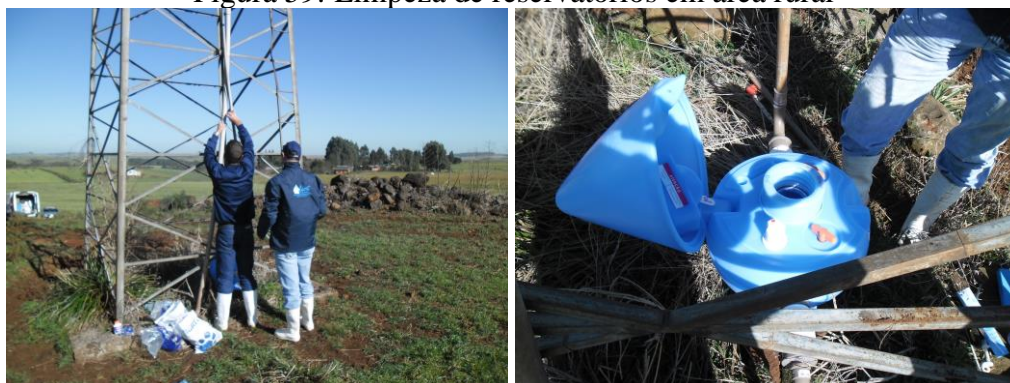
Figura 59: Limpeza de reservatórios em área rural
