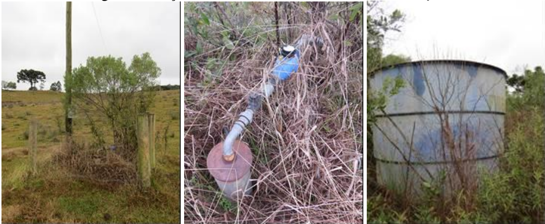
Figura 53: Poço artesiano e reservatório– Rincão Comprido
