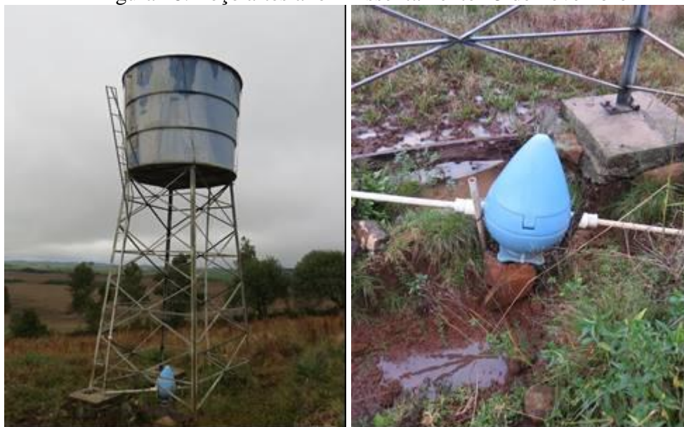
Figura 48: Poço artesiano – Assentamento 25 de novembro
